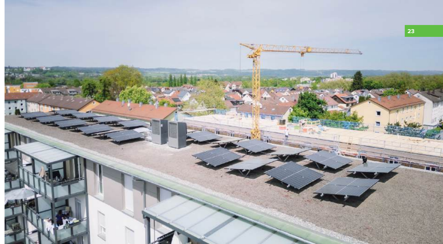
Energetische Sanierung in Weingarten: Die erste eigene Photovoltaikanlage der Genossenschaft wurde erfolgreich in Betrieb genommen.
