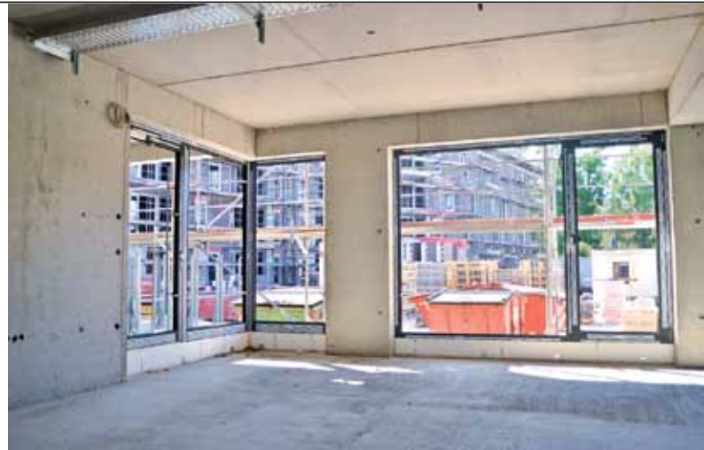
Erste "Ausblicke" aus dem Rohbau Haus B auf das Haus E
