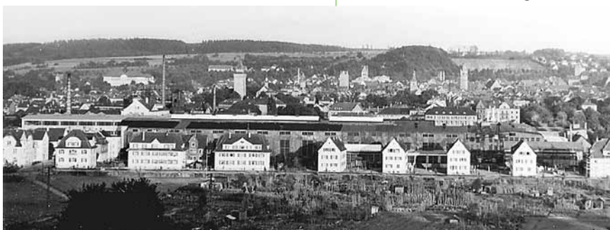
Doppelwohnhausbau in den Rechenwiesen
