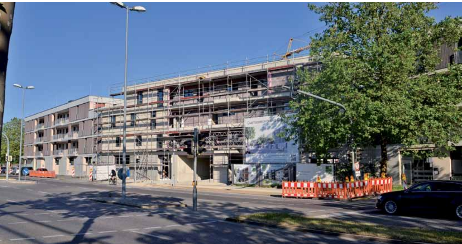
Das Verbindungshaus (B) mit der Tiefgarageneinfahrt zwischen den bereits bezogenen Häusern (C + A) ist weit fortgeschritten
