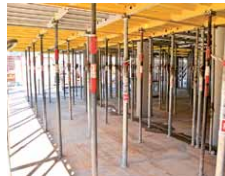
Tiefgaragenabstützung bis zur vollständigen Austrocknung
