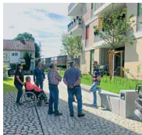
Begehung des Neubaus im Quartier Galgenhalde
