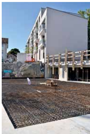
Tiefgaragenabstützung bis zur vollständigen Austrocknung
