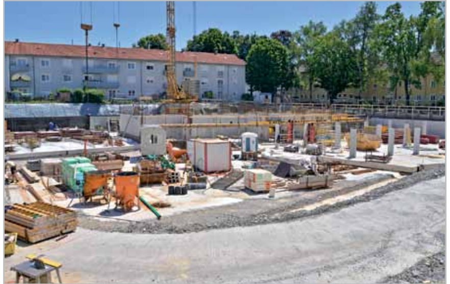
Weitere Baufortschritte in der Galgenhalde. Die Tiefgarage bildet das Fundament für zwei weitere Wohnhäuser innerhalb dieser wichtigen Quartiersentwicklung
