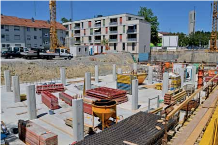
Blick auf den vermieteten Bauabschnitt I und den Aufbau der Tiefgarage
