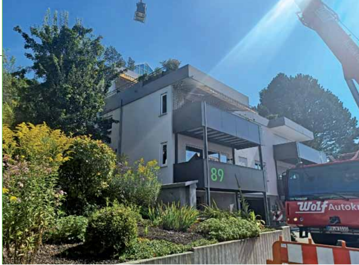
Aufgrund der Hanglage der WEG wurde die Heizung kurzerhand mit einem Kran über das Gebäude gehievt
