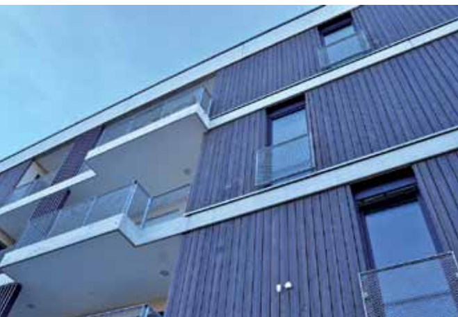
Die Nordseite des Bauabschnitts I präsentiert sich mit harmonischen Holzelementen
