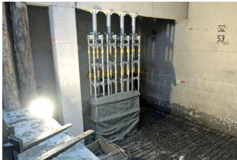
Provisorische Stützen dienen zur Verstärkung der Statik während der Sanierungsarbeiten
