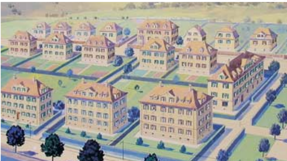
Gemälde der Siedlung beim Kraftwerk, Gartenstraße, allerdings nicht vom Bau- und Sparverein, sondern 1924/26 von der Stadt gebaut. Saniert wurde sie aber komplett vom Bau- und Sparverein als Projektsteuer.
