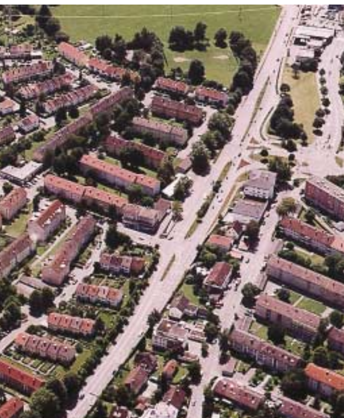
Das Wohngebiet in der Galgenhalde
