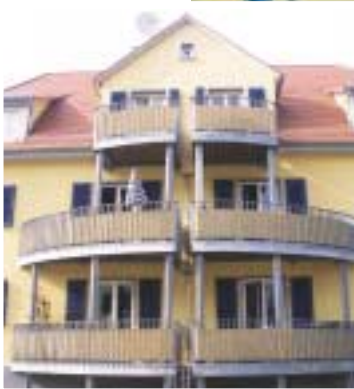
Ein im Jahr 2000 saniertes Gebäude in der Wohnanlage Ziegelstraße/Bismarckstraße
