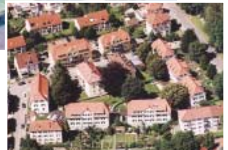
Luftaufnahme der sanierten Gebäude in der Ziegelstraße und in der Bismarckstraße
