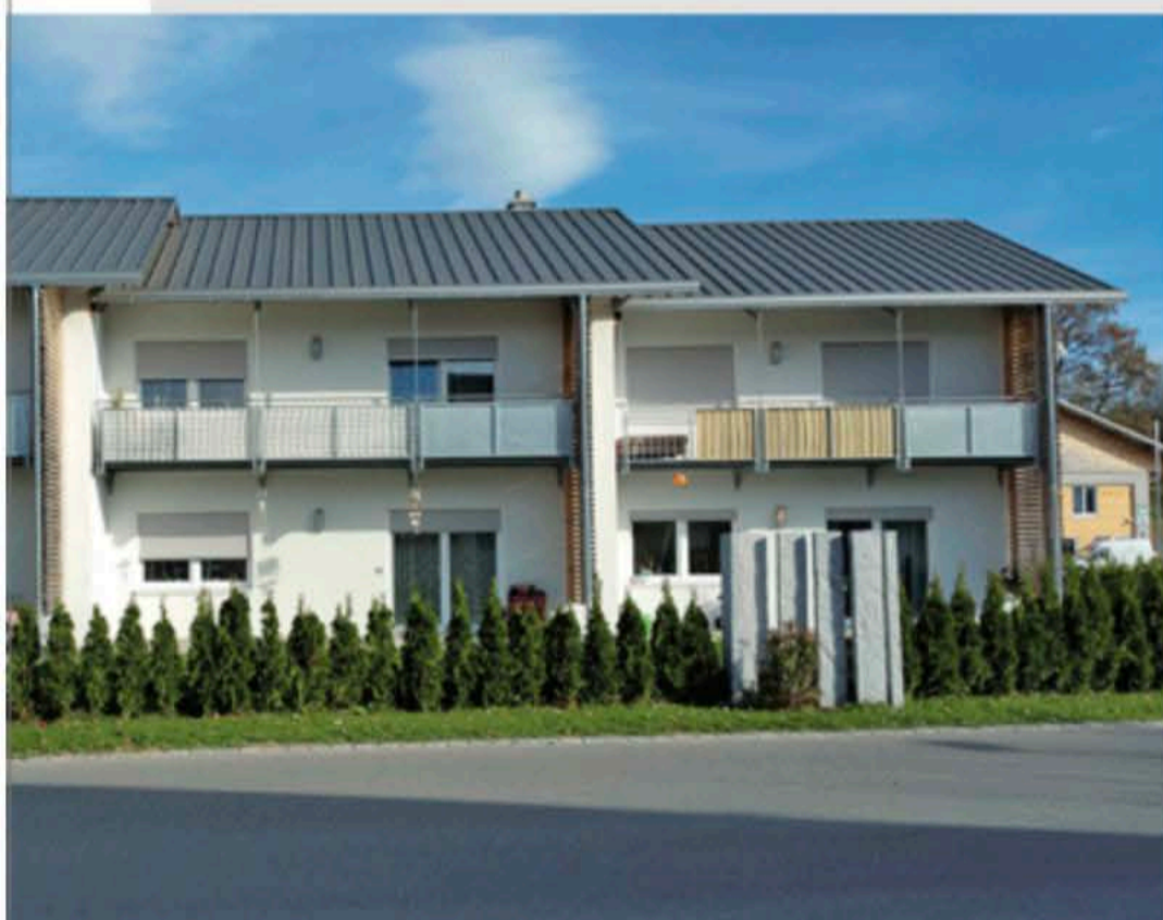
Referenzgebäude in Schlier bei Ravensburg für 18 Bewohner – zweigeschossig in KfW-40 Standard Massiv- bauweise mit Keller.
